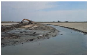
3 Curage d'un canal
